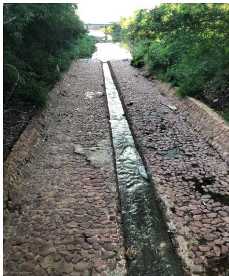
**Figura 104** Ejemplo de canal de aguas bajas en el Arroyo Jaén
