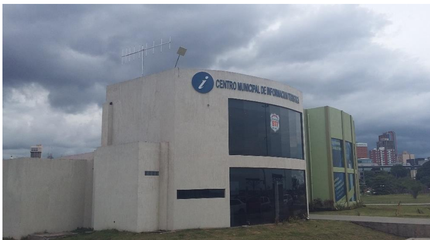
Figura N° 41. Ubicación de la antena Motus sobre el techo del Centro Municipal de Información Turística (foto Arne Lesterhuis)
